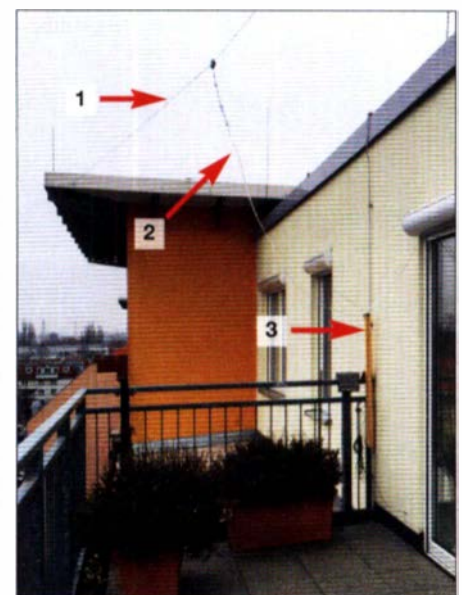
Bild 2: Der 2 × 7-m-Dipol (1) ist zwischen zwei Flachdachecken gespannt. Das Flachbandkabel (2) führt durch die Balkontür ins Zimmer und zur Station. Die Abspannseile verlaufen über Umlenkrollen zur Abspannvorrichtung (3), Bild 1.
